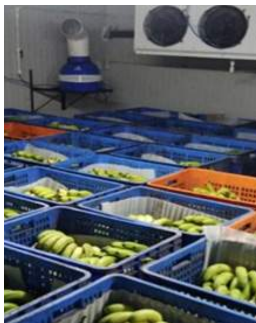
Chambre de maturation industrielle avec réfrigération et contrôle du gaz (Crédits: Nilkamal)
