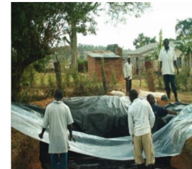
a) Creuser une tranchée et la tapisser de bâches en plastique
