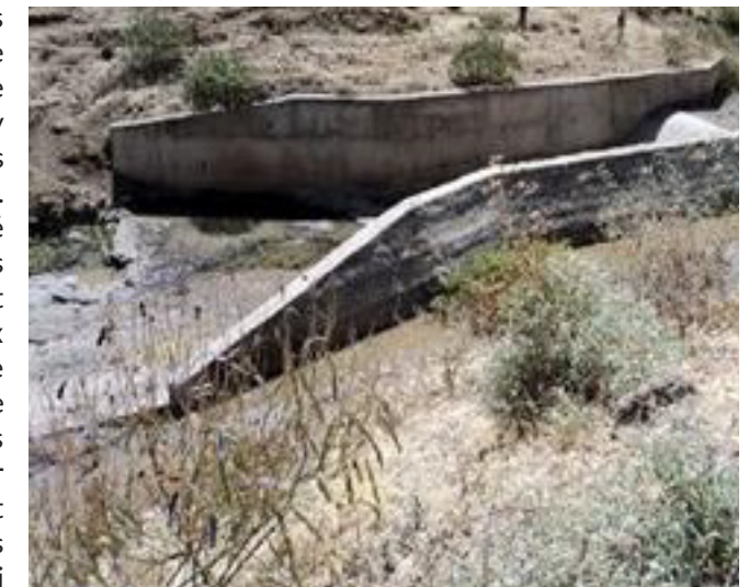
Détournement d'un cours d'eau saisonnier
