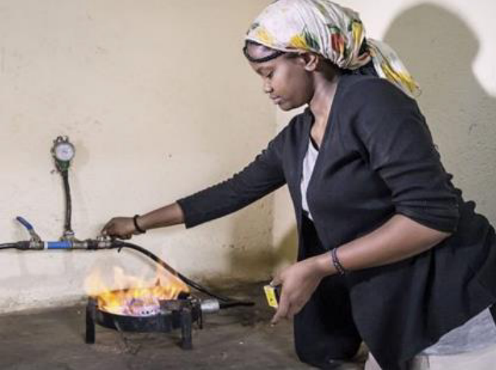
Cuisiner avec du biogaz produit à partir de déchets agricoles; notez le manomètre et les valves
