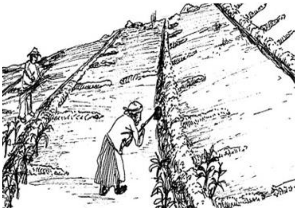
L'établissement de digues de contour, notez de courtes crêtes perpendiculaires qui empêchent le ruissellement
